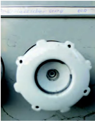
Schmelzsicherung mit Knopffarbe «silber» Anschlusswert bezeichnet 80 A.
